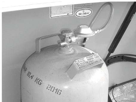
Fig. 64 : Bouteille de gaz avec détendeur basse pression et flexible basse pression
