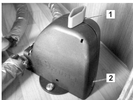
Fig. 117 : Vanne de vidange de sécurité fermée
