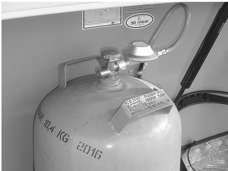
Fig. 83: Bouteille de gaz avec détendeur
